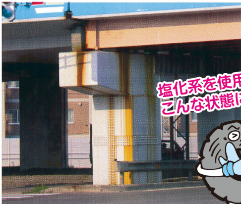
塩化系凍結防止剤による錆の様子
